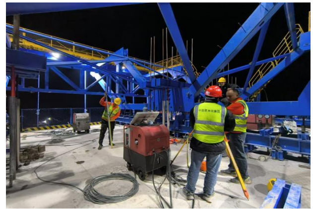
(a) 挂篮桁架及吊带结构变形测量
